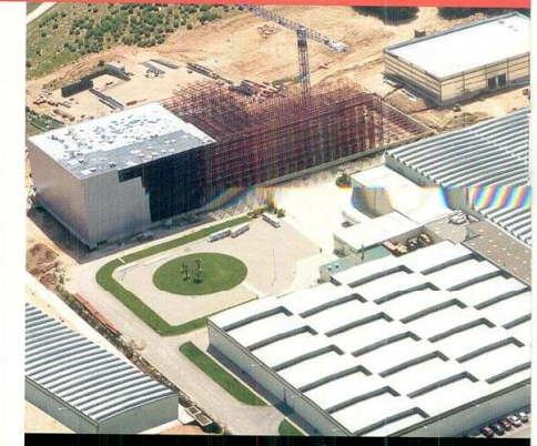
Vista general Instalaciones García de Pou en Ordís (Girona)
