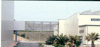
Pasarela aérea de comunicación Fábrica-Recepciones mediante transporte automático
